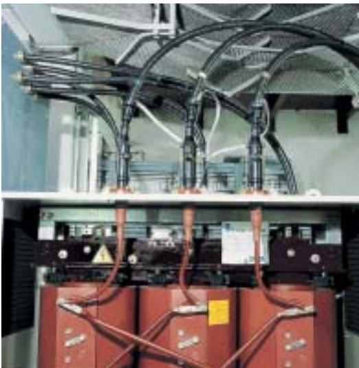
250 A przepusty wtykowe i rozdzielne konektory SN na obudowie IP31
