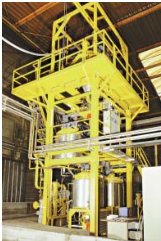
Proces wykonywania zalewy SN
