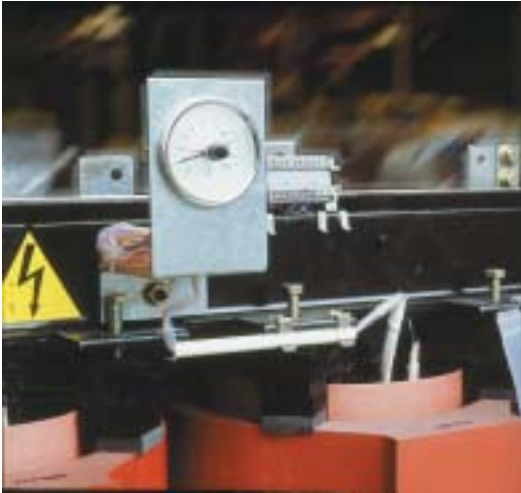
Termometr tarczowy dla transformatora bez obudowy (IP00)
