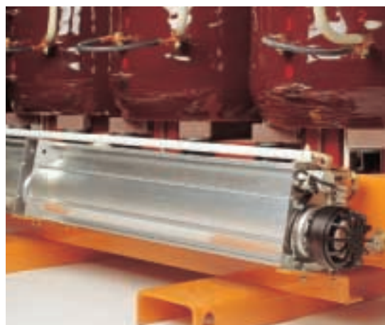
Chłodzenie przez wymuszony obieg powietrza
